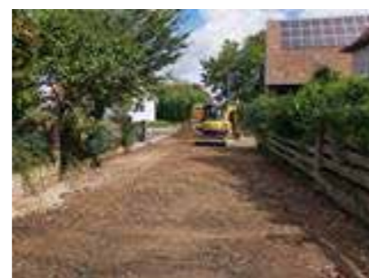
Travaux rue de la Fecht
