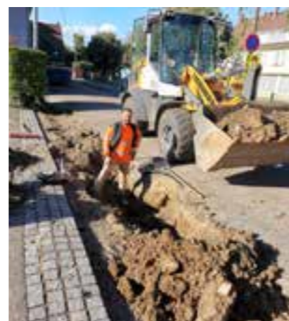
Travaux rue de Collonges
